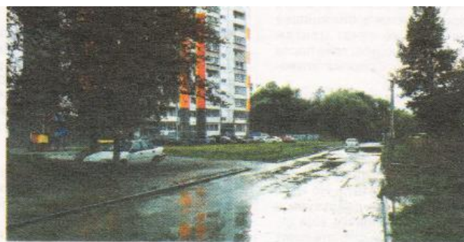
Обычная прочистка «ливневки» и повышение уровня асфальта не дали результата – нужна масштабная реконструкция устаревшей системы дождевой канализации в районе
